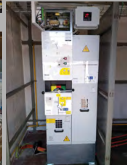
Esercito Caserma Mater: sostituzione cella MT
