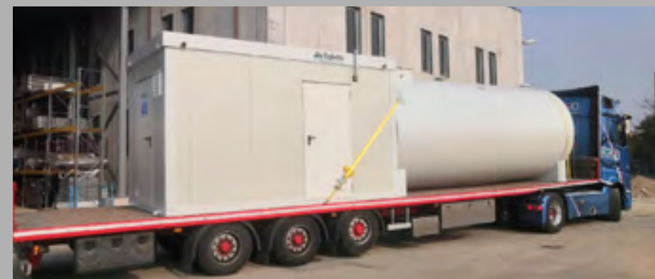
Sonepar Selvazzano: posa gruppo di pompaggio pressurizzazione antincendio
