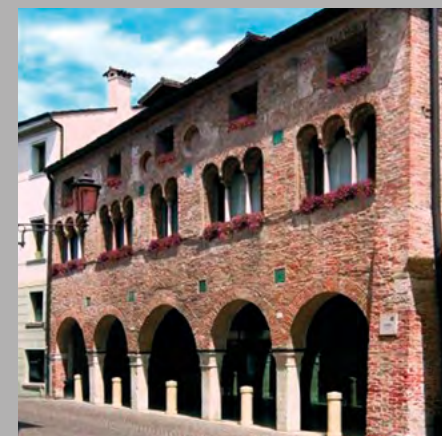
Fondazione Cassamarca Treviso: immobile Ca' dei Carraresi manutenzione elettrica meccanica, antincendio. Conduzione caldaie
