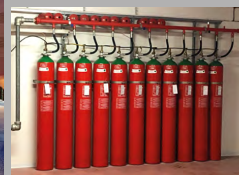
Veritas Mestre (VE): manutenzione antincendio CDO1
