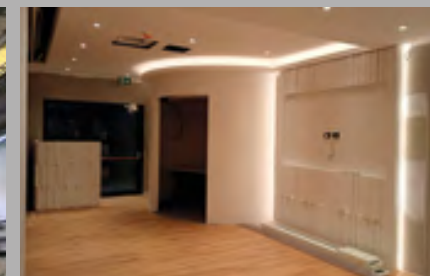
CMB: realizzazione impianti elettrici meccanici Ponzano (TV)
