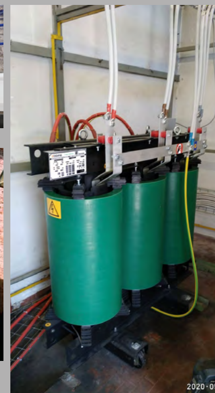
Esercito: sostituzione trasformatore MT/BT
