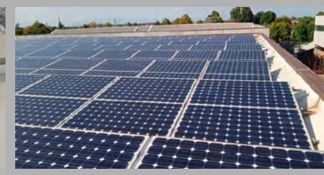
Privato: realizzazione impianto fotovoltaico 200 kw a Dosson di Casier
