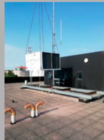
Comune di Jesolo: sostituzione gruppo frigo
